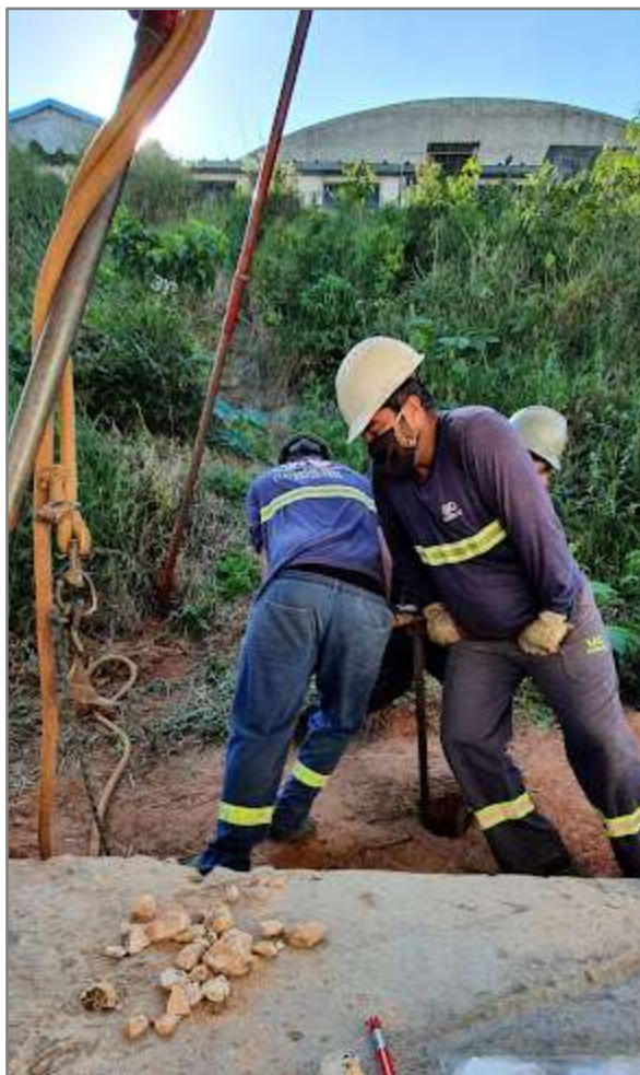
FIGURA 2 – Sondagem do tipo manual com o uso de trado manual
